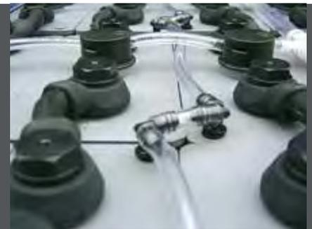
**"Version-Z":** version Air-Tech: des éléments avec circulation d'acide c.-à-d. chaque élément contient un petit tube dans lequel le chargeur pompe une petite quantité d'air qui fait circuler l'électrolyte dès le début de la charge. (cf. schéma)
